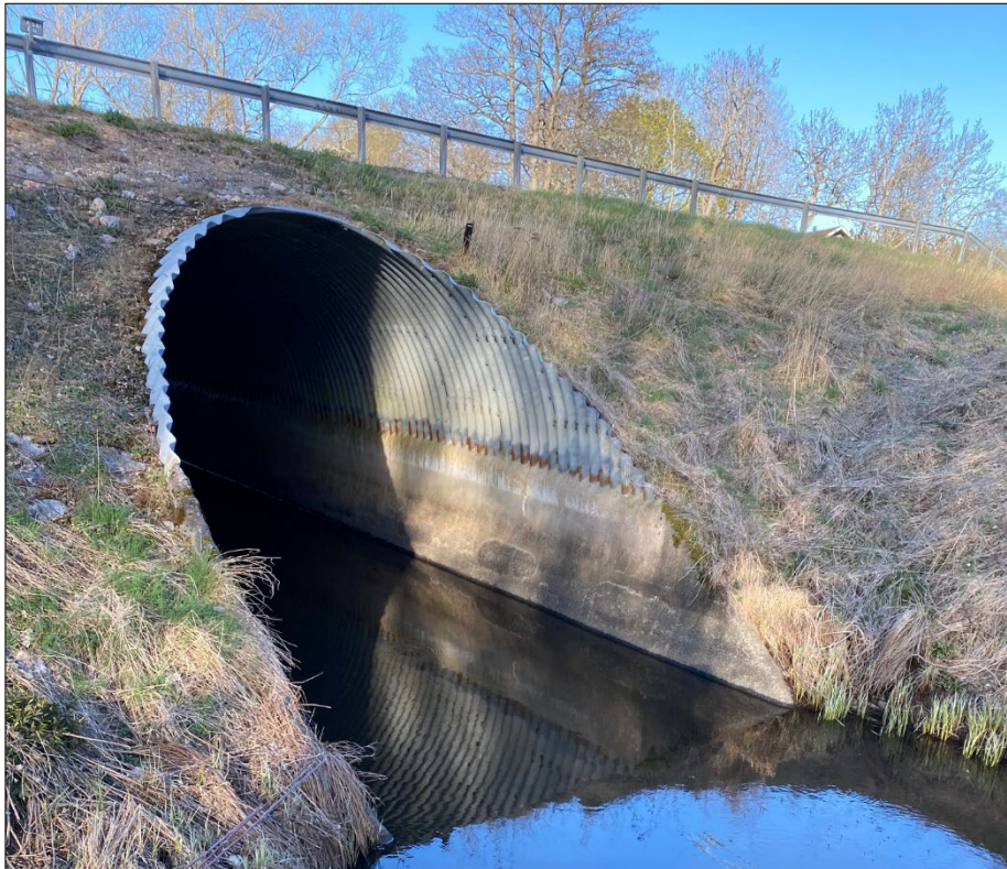
Figur 14. Rörbro (nr 19-286-1; Trafikverket 2020) med okänd grundläggning cirka 500 m nedströms det nya dammläget vid Svanviken (foto Staffan Lund).
