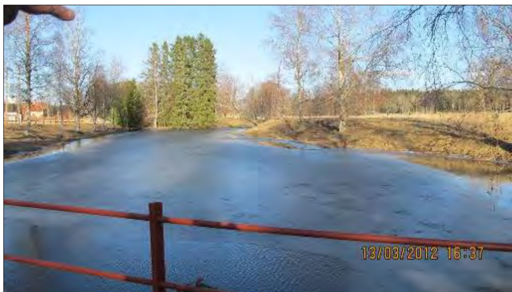
Figur 11. Vy från Starfordsdammen och uppströms.
