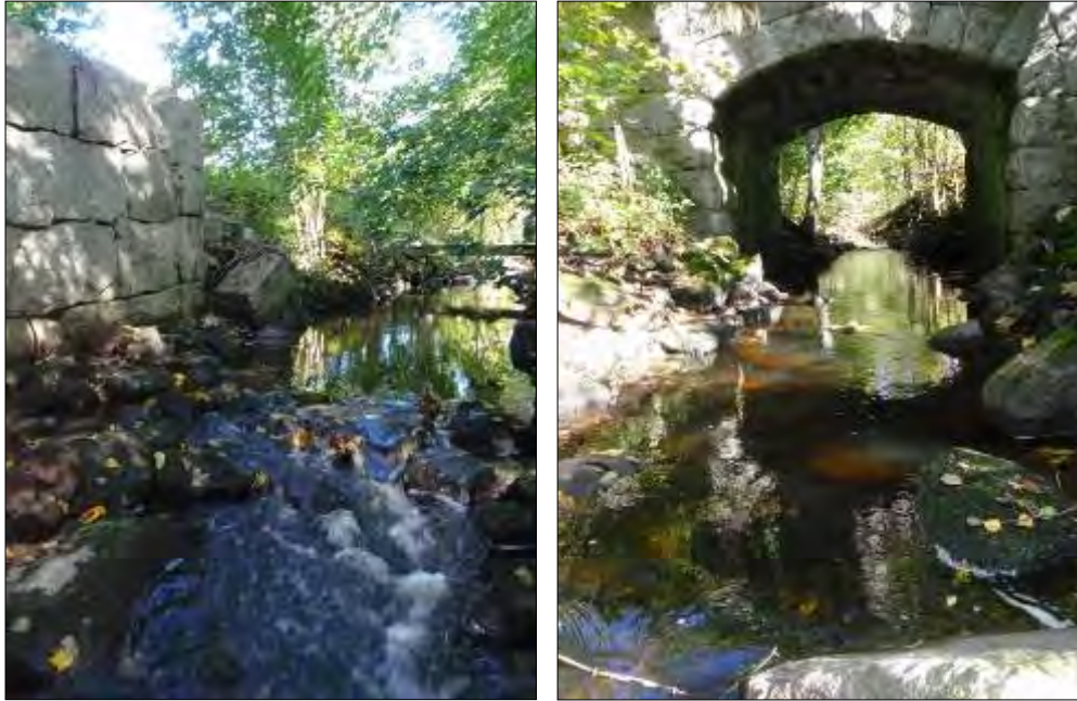
Figur 4 och 5. Vid Molnebo gård finns två forsackar. Det vänstra fotot visar en forsacke strax nedströms stenbron vid Molnebo gård. Det högra fotot visar en forsacke vid en äldre husgrund uppströms stenbron vid Molnebo gård. Denna forsacke utgör den första bestämmande sektionen nedströms sjön och därmed Vansjöns egentliga tröskel.
