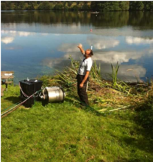
Figur 1 Banarpssjön – Linor/motor som drar muddringutrustningen
